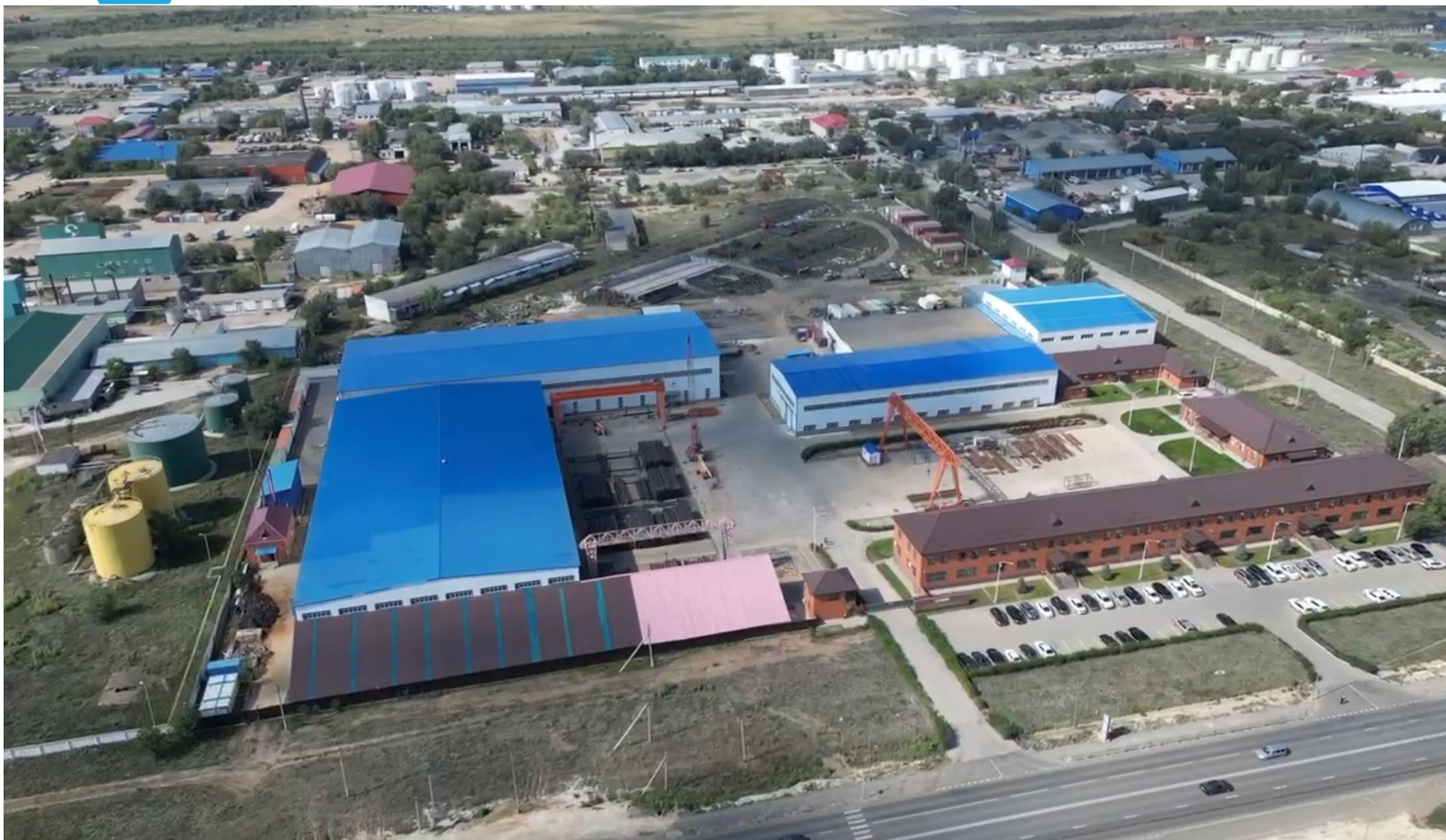
Панорамный вид на Казахстанский завод нефтяного оборудования
